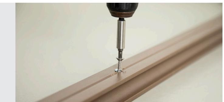
Coloque las grapas con ayuda de una maza de nylon y sujetela con tornillos al rastrel.
