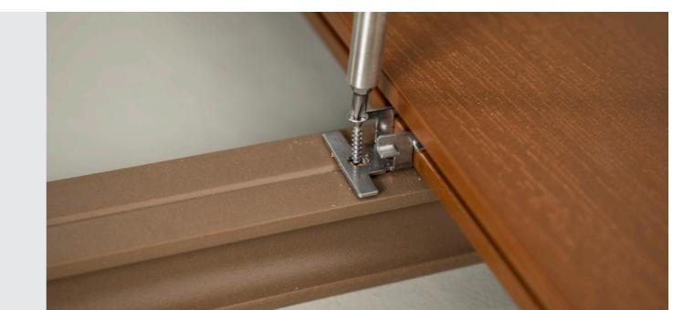
Coloque el siguiente perfil insertándolo en las grapas ya sujetas. Utilizar doble rastrel al final de la lama.
